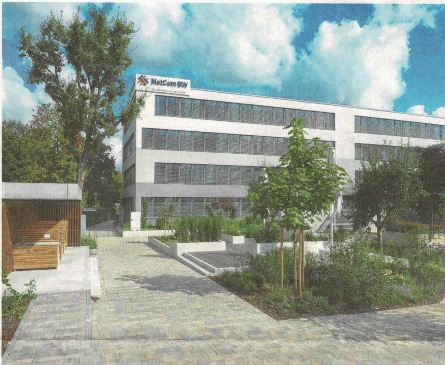
Der Neubau ergänzt und vergrößert den bestehenden Stammsitz von ODR und NetCom in Ellwangen.
